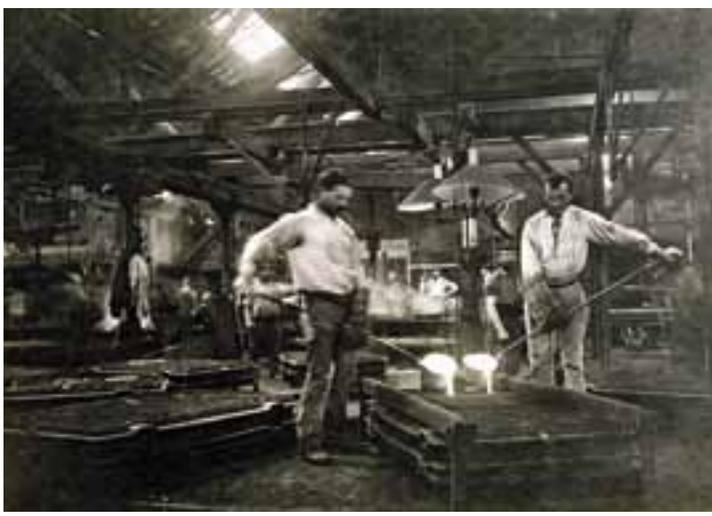
7. Les pièces sorties des moules doivent être nettoyées du sable encore adhérent et libérées des éléments résultant du moulage (la fonte de remplissage des canaux par lesquels se fait la coulée et s'évacue l'air) ; elles passent ensuite au meulage où sont supprimées les bavures.
